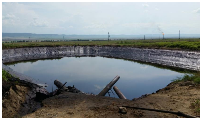
Рисунок 25 - Нефтешламовый амбар в Наурском районе (август 2016 г.)
