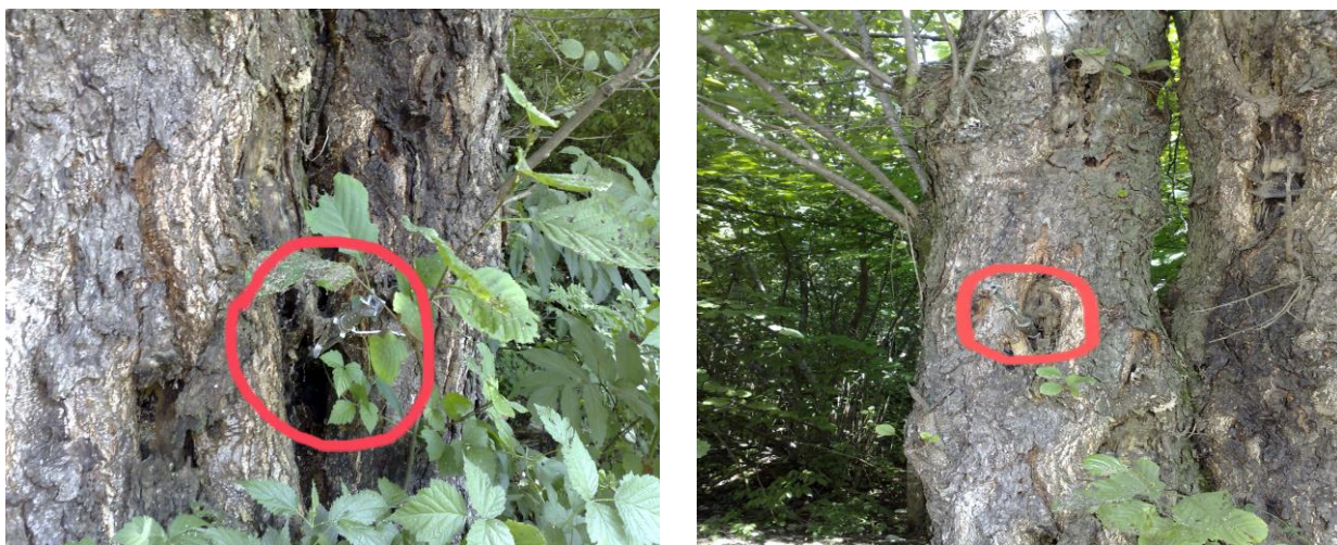
Рисунок 12 - Снаряд (обведен красной линией) в дереве в Веденском районе (июль 2012г.) (слева); поврежденный снарядом и «болезнью» ствол дерева в Шатойском районе (июль 2012 г.) (справа)
