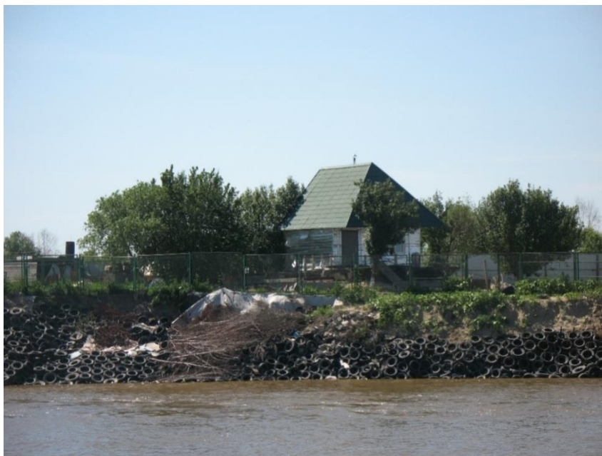
Рисунок 91. Укрепление левого (российского) берега от размыва в р-не г.Хабаровск (фото Е.К. Губарева)
