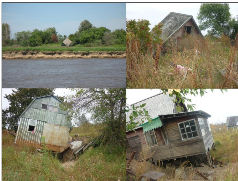
Рисунок 83. Разрушенные дома на о-ве Большой Уссурийский (фото Е.К. Губаревой, 2014)
