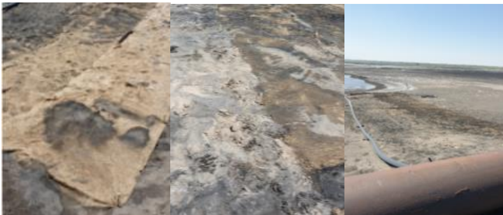
Рисунок 4.24 - Биоматы на ложе и ближе к дамбе (к откосу) хвостохранилища II (фото автора)
