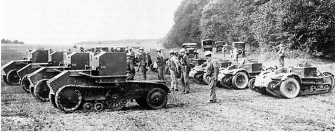
Рис. 10. Две секции 3-го батальона КТК, разведывательное подразделение ЭМС. В первом ряду четыре танкетки производства Morris-Martel, за ними пять танкеток Carden-Loyd Mk. Vs. 1927 г. Источник: Fletcher D. Mechanised Force: British Tanks Between the Wars. L.: H.M. Stationery Office, 1991. P. 63
