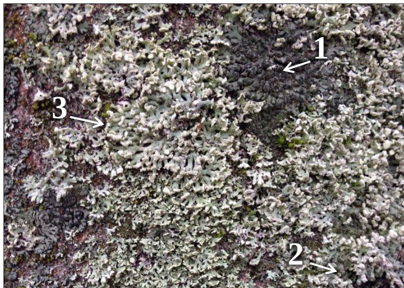
Рисунок 21 – Плотное покрытие ствола дерева нитрофитными лишайниками:
