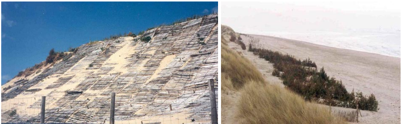
Рисунок 4.25 – А) – Укрепление абрадированного склона авандюны матами (Великобритания); Б) – Применение использованных новогодних елей в качестве пескоудерживающих конструкций (Нидерланды)
